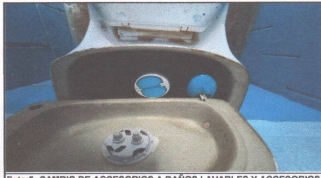
Foto 5: CAMBIO DE ACCESORIOS A BAÑOS LAVABLES Y ACCESORIOS DE FONTANERIA ( CHORRO, LLAVE DE PASO, TUBOS)
