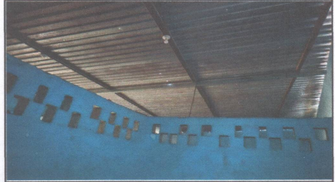
Foto 2: LEVANTAMIENTO DE MURO QUE DIVIDE AULAS PARA MAYOR SEGURIDAD DE EQUIPO DE LABORATORIO.
